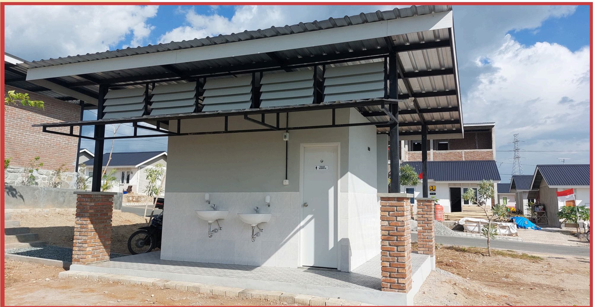
Bangunan toilet yang disediakan pada fasilitas kuliner UMKM di Huntap Talise Palu. (Sumber: Dok.BPKPT Kadin)
